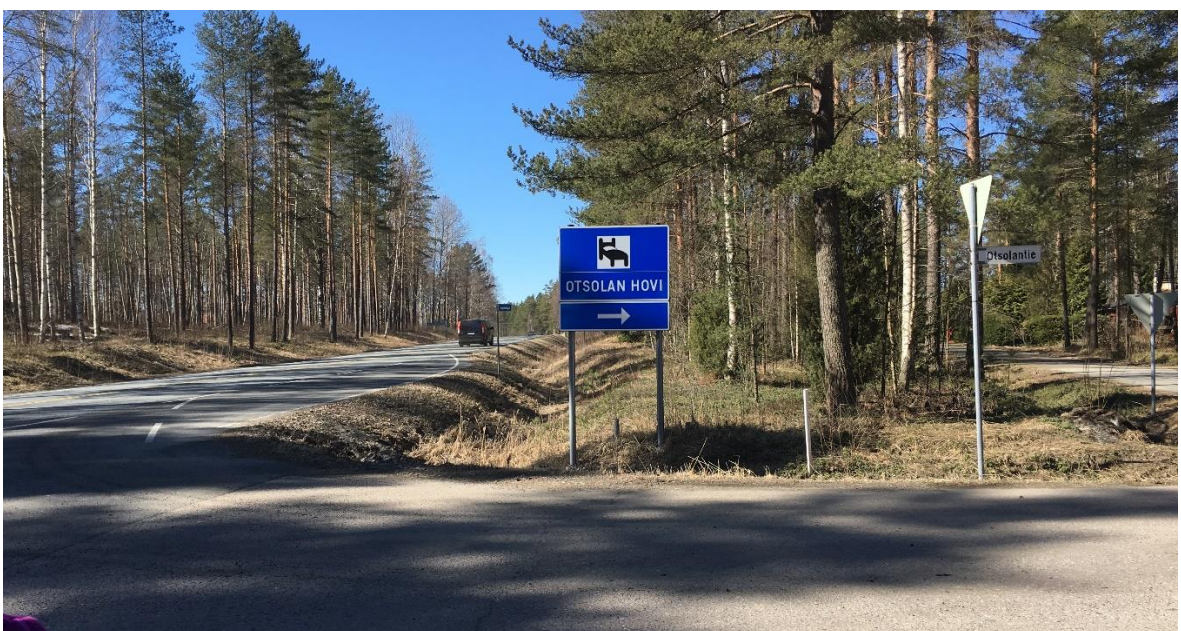
Kuva 11. Jalankulku- ja pyörätie päätetään kuvassa näkyvään Otsolantien liittymään, jonka jälkeen yhteys on Vanhatien ajoradalla (kuvassa oikealla).
