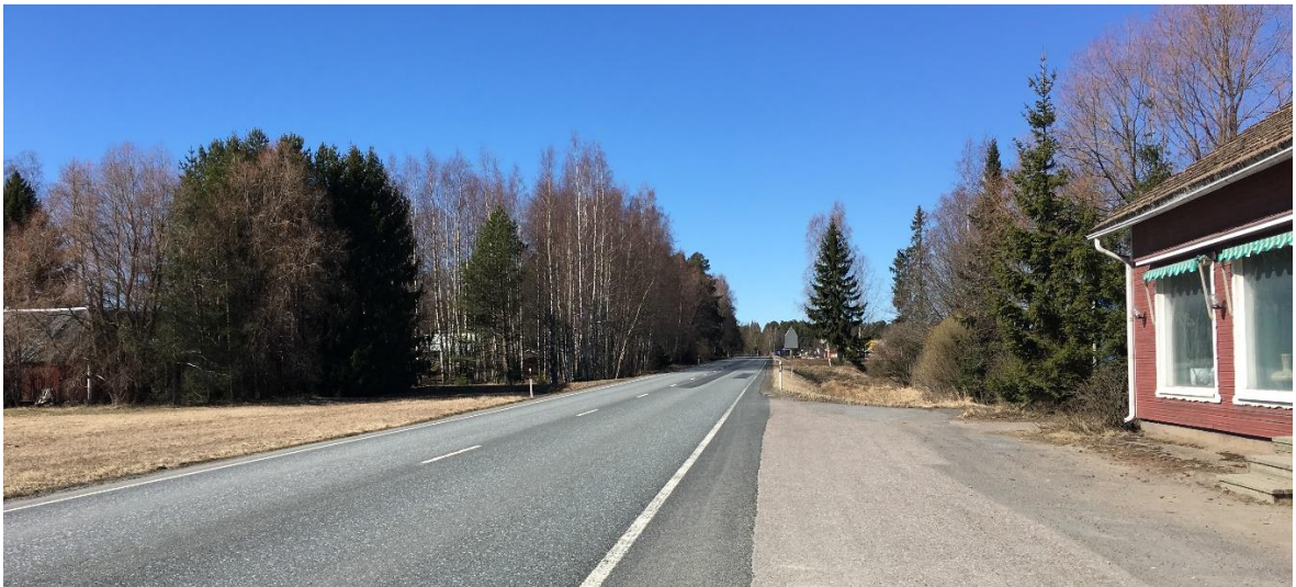
Kuva 10. Kesonkulmantien liittymän kohdalla asuinrakennusten ja valtatie 2 välissä ei ole riittävästi tilaa, joten välikaista on tehtävä ohjearvoa kapeampana noin 100 m osuudella.
